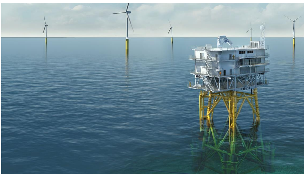
Figur 9 Illustration av en bottenfast transformatorstation i en vindpark till havs (Illustration: Ramboll).
