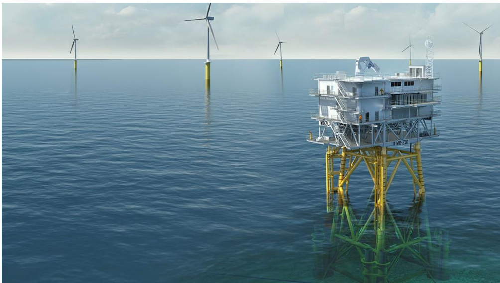
Figur 9. Illustration av en bottenfast transformatorstation i en vindpark till havs (källa: ramboll.se)
